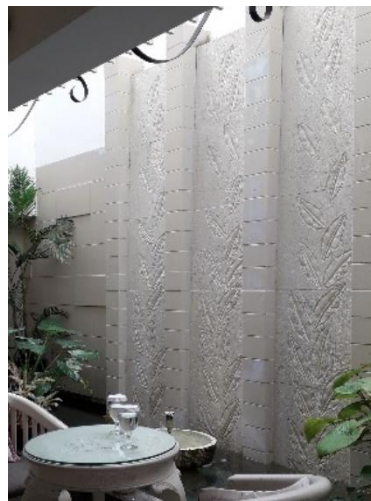
Gambar 4. 6 Penerapan material batu paras pada dinding Sumber : Data pribadi
