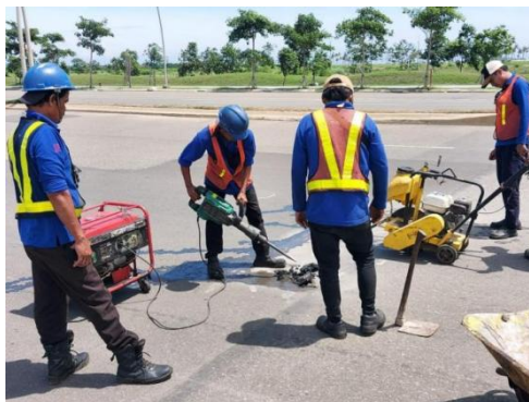
Gambar 3. 3 Proses Pemotongan Lapisan Perkerasan Jalan yang Rusak dengan Asphalt Saw
