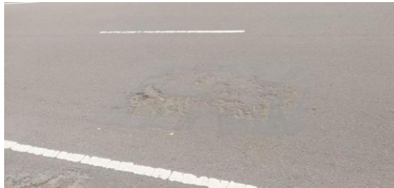
Gambar 3. 2 Lapisan Permukaan Jalan yang akan di-Patching
