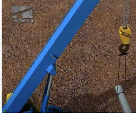
Gambar 2. 3 Ilustrasi Pengangkatan Tiang Pancang
