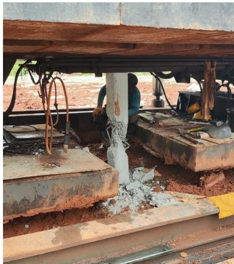
Gambar 4. 10 Kondisi Tiang Pancang Patah atau Pecah
