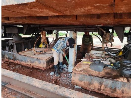
Gambar 4. 5 Pemotongan Tiang Pancang
