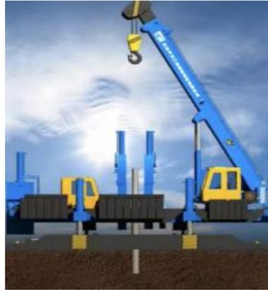
Gambar 2. 5 Ilustrasi Penekanan Tiang Pancang Pancang
