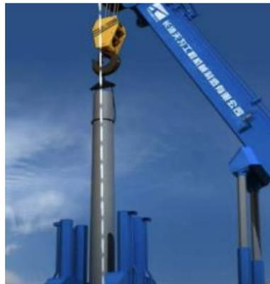
Gambar 2. 6 Ilustrasi Pemeriksaan Vertikalitas
