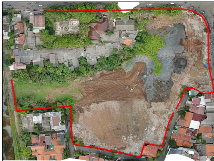
Gambar 3. 1 Lokasi Pembangunan SPAM Bekasi Sumber: (WIKA – Jaya Konstruksi KSO, 2022)
