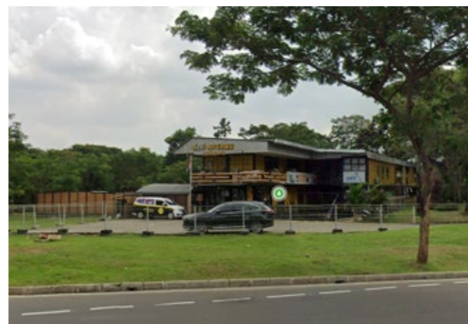
Gambar 3.66. Tampak Samping Woof Avenue. (sumber: dokumentasi penulis)
