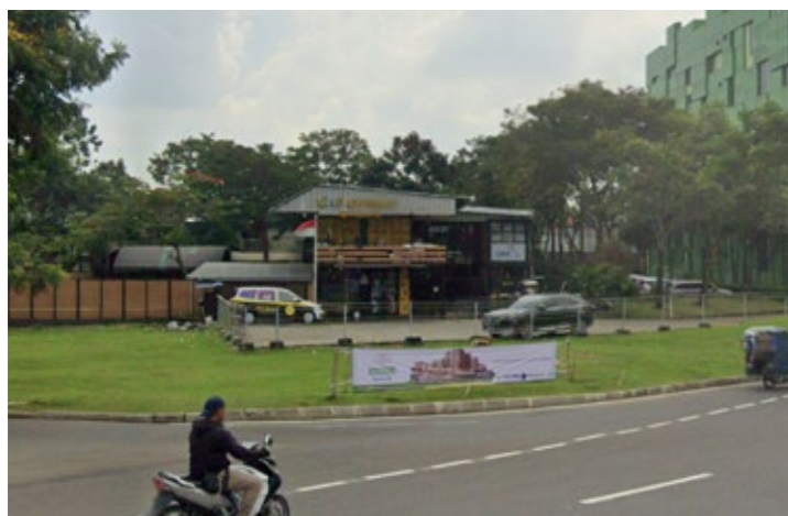
Gambar 3.65. Tampak Depan Woof Avenue. (sumber: dokumentasi penulis)
