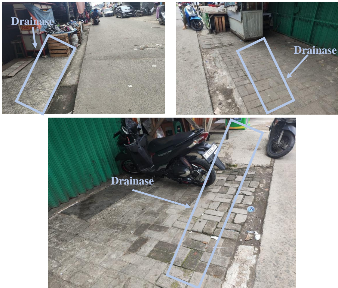
Gambar 5. 5 Penutupan Selokan Dengan Perkerasan Permanen Tanpa Celah Jalur Air
